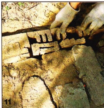
Целый и битый кирпич, а также куски тротуарных плит использованы для покрытия дорожки от дома до калитки.
