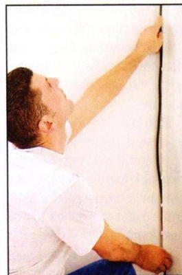
Укладка провода в кабель-канал.
