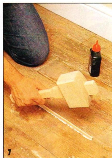
7 На поверхности планки наносят клей, вставляют её в щель и осаживают киянкой.
