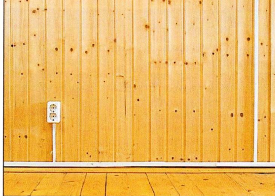
Входящий провод часто ведут над полом, а отводы поднимают к розеткам и выключателям вертикально вверх.
