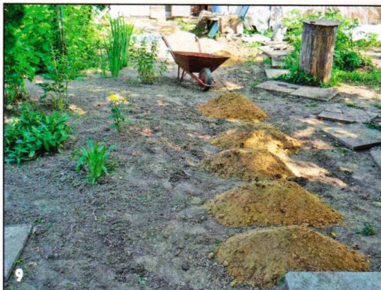
Предварительно сняв верхний слой грунта, заполняют траншею песком.
