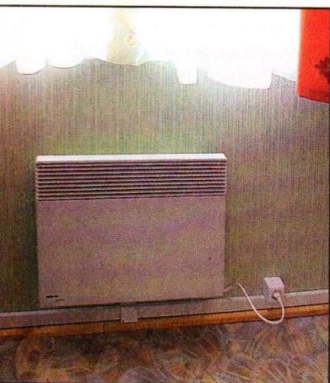
С помощью кабель-каналов довольно удобно подводить питание к электрообогревателям, смонтированным на стенах.
