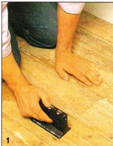
1 Металлоискатель покажет, есть ли под половицами провода или трубы.
